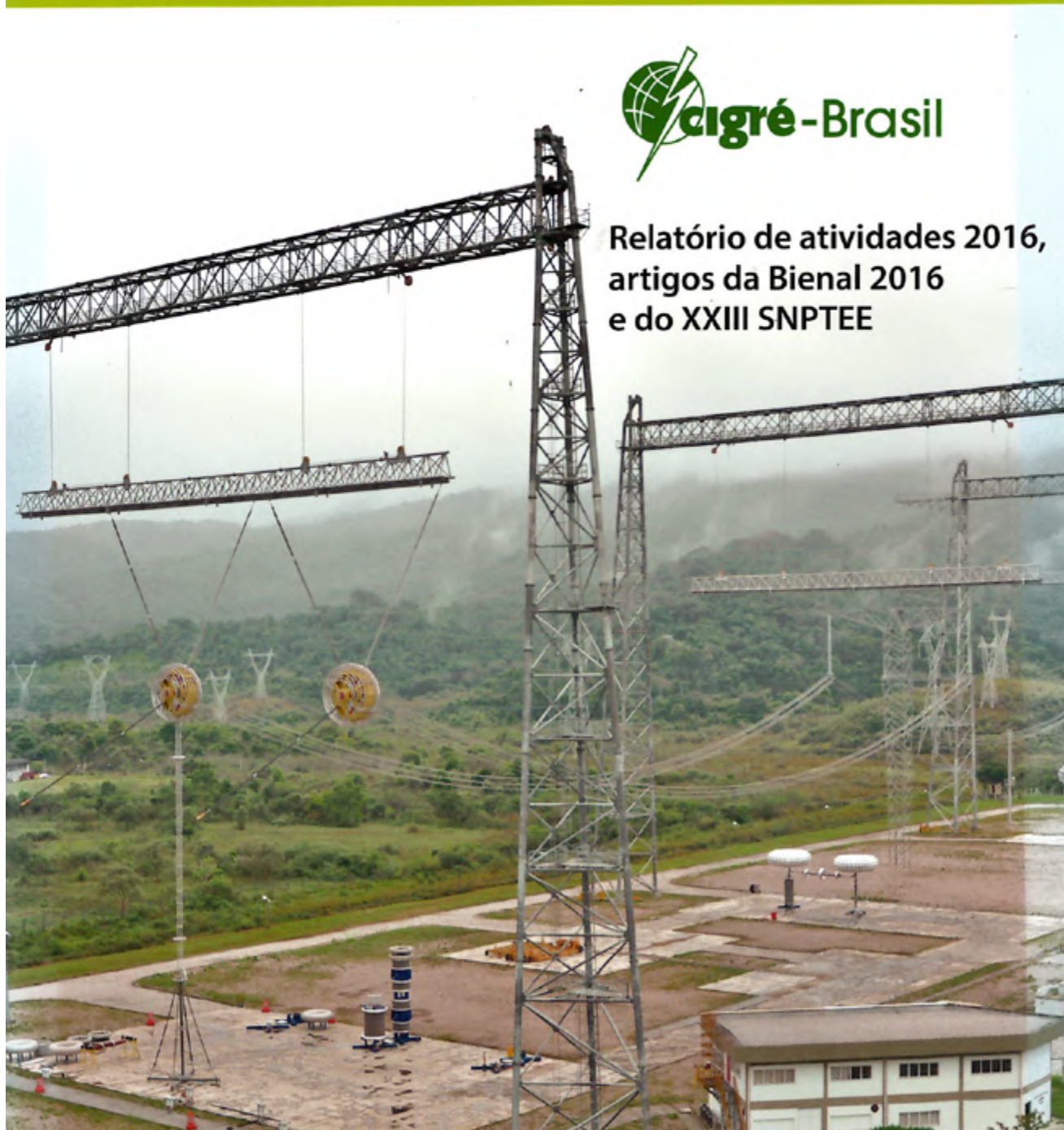
Laboratório de Ultra Alta Tensão Externo do CEPEL Eletrobrás.
